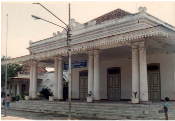
Gb.9. Bekas rumah kel. Han, di Jl. Hansanudin, Pasuruan. Kel. Han adalah salah satu keluarga China yang terkemuka di Jatim. Denah dan tampak depan rumah dengan pilar gaya Yunani dan teras depan maupun belakang yang luas tersebut jelas mengacu pada bentuk arsitektur "Indische Empire" yang populer pada abad ke 19.
