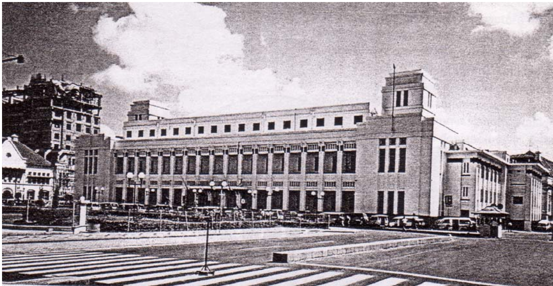
Gb.16. Gedung Internatio di Jl. Rajawali, Surabaya. Dirancang oleh biro AIA (pimpinan Ghijsels) pada th. 1927-1931. Gedung ini merupakan salahsatu bangunan yang paling besar di daerah perdagangan sekitar Jembatan Merah , Surabaya.
